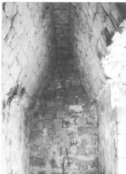
Fig. 5. Gewölbe in einem Bauwerk in Santa Rosa Xtampak, Campeche. Chenes-Stil.
