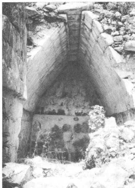
Fig. 6. Gewölbe in Bauwerk 1 in Dzúlá, Yucatán. Puuc-Stil.
